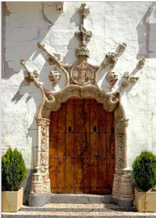
Portal manuelino. Olivenza (Extremadura).
